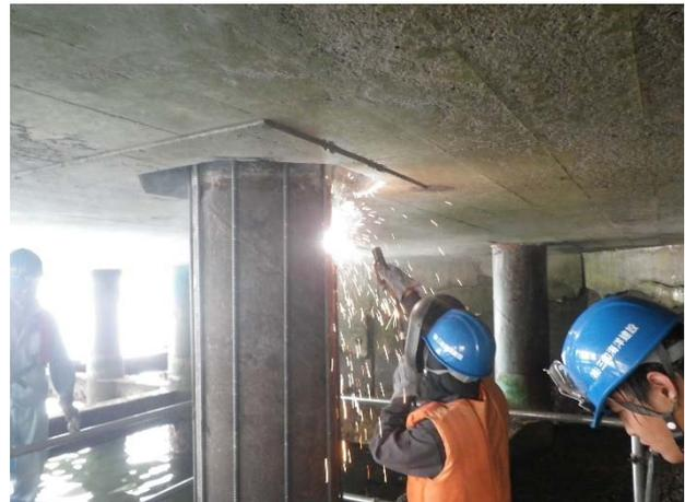
d) 定着鉄筋溶接状況
