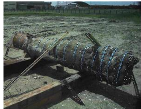
図-20 根固め形状測定状況
