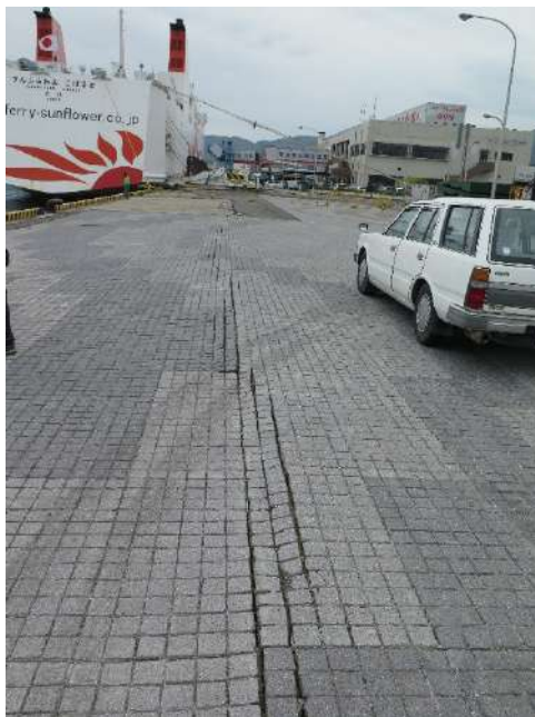
写真-5.1 石垣地区第三埠頭岸壁 (-12m) エプロン部のクラック (2016年4月18日撮影)
