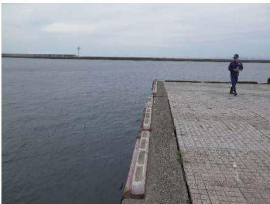
写真-5.4 石垣地区第三埠頭岸壁（-12m）側面護岸における護岸法線のずれ（2016年4月18日撮影）
