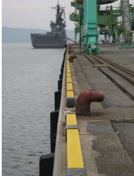
写真-6.4 岸壁法線（北東方向を臨む）
