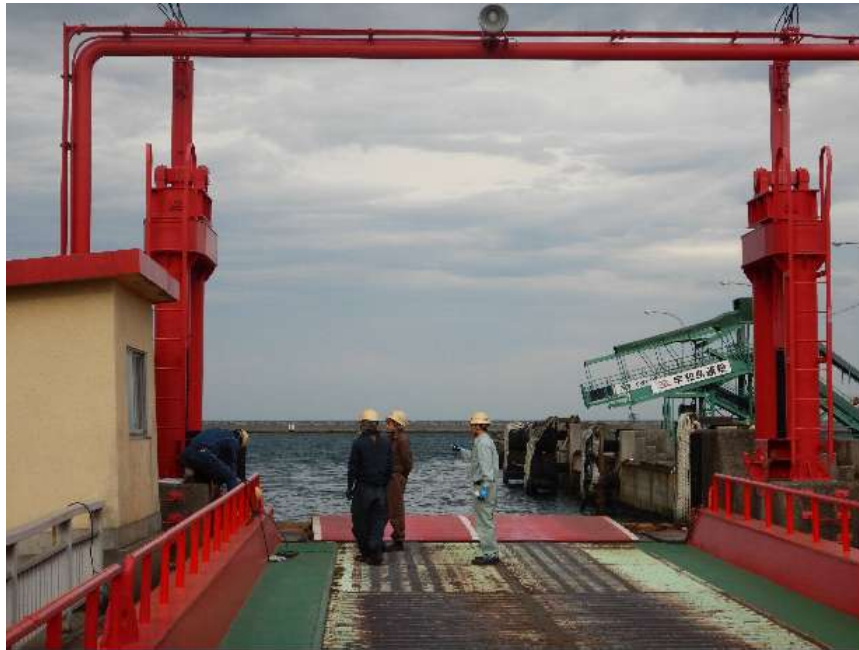
写真-5.9 石垣地区第二埠頭可動橋の全景
