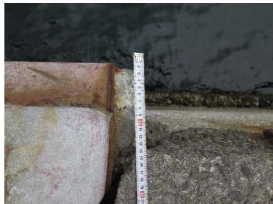
写真-5.4 石垣地区第三埠頭岸壁（-12m）側面護岸における護岸法線のずれ（2016年4月18日撮影）
