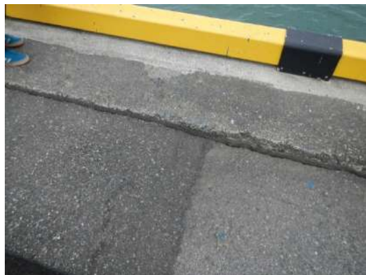
写真-6.8 アスファルト舗装の補修跡
