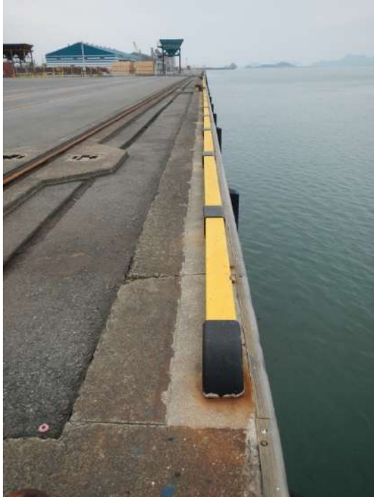
写真-6.3 岸壁法線（南西方向を臨む）
