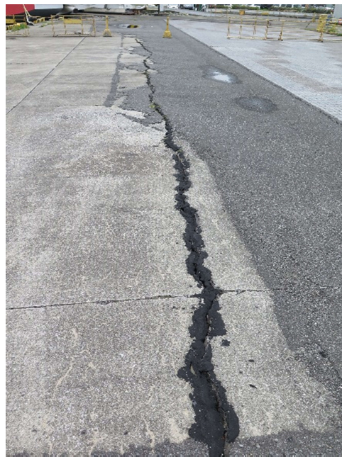
写真-5.1 石垣地区第三埠頭岸壁 (-12m) エプロン部のクラック (2016年4月18日撮影)
