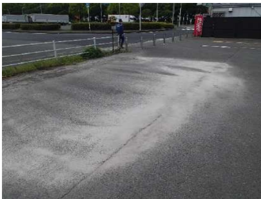
写真-5.3 石垣地区第三埠頭岸壁（-12m）エプロン背後の駐車場で3箇所の液状化痕（2016年4月18日撮影）
