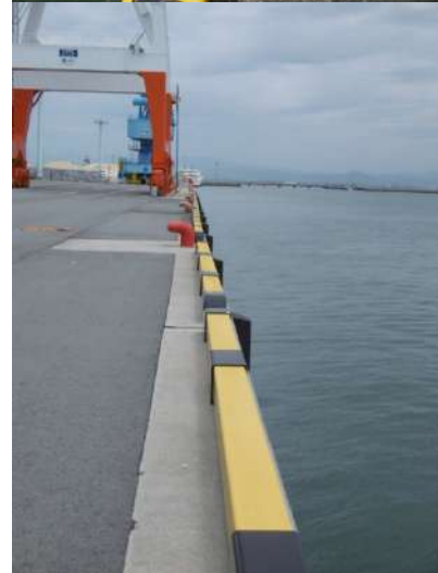
写真-4.1 岸壁（-7.5m）（図-4.1の①）の法線上から西（上の写真）および東（下の写真）を見た状況（2016年4月16日撮影）
