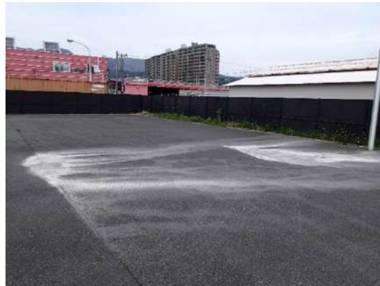
写真-5.3 石垣地区第三埠頭岸壁（-12m）エプロン背後の駐車場で3箇所の液状化痕（2016年4月18日撮影）
