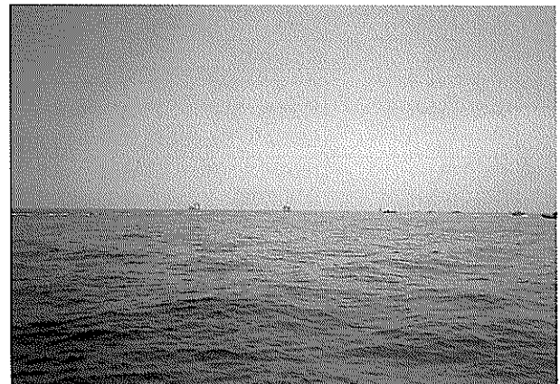
写真-2 試乗調査当日の関空2期工事現場
