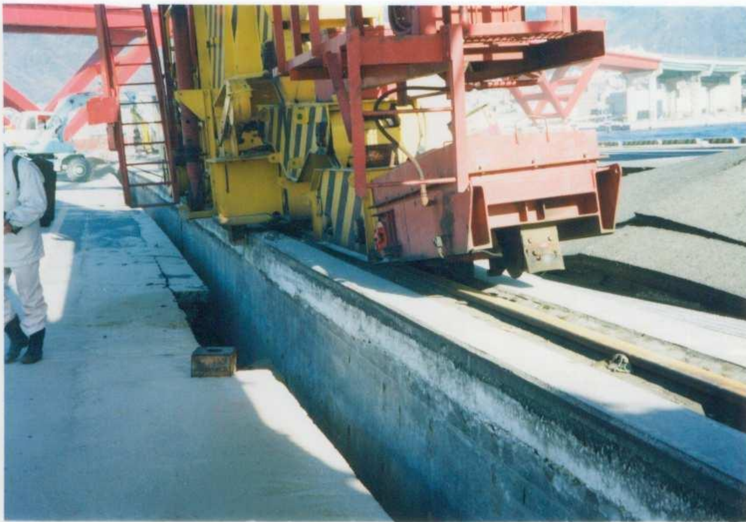
陸側レール基礎が杭基礎の場合 (摩耶埠頭コンテナターミナル東側岸壁)
