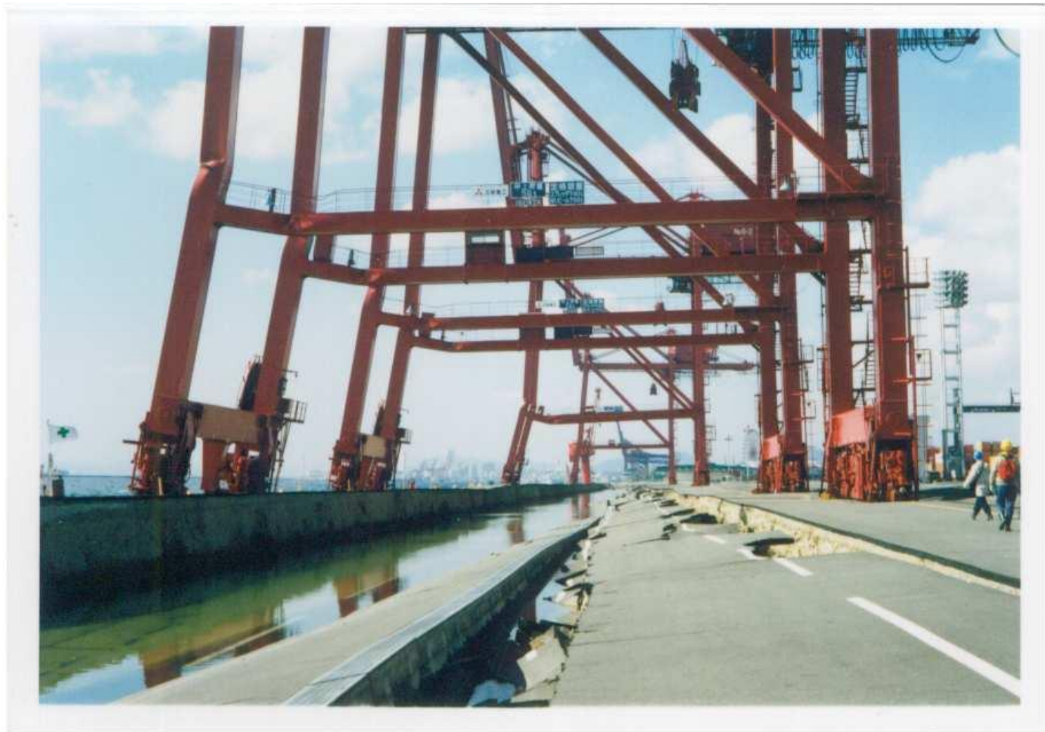
陸側レール基礎が地盤改良の場合 (六甲アイランド南側岸壁RC-6～RC-7)
