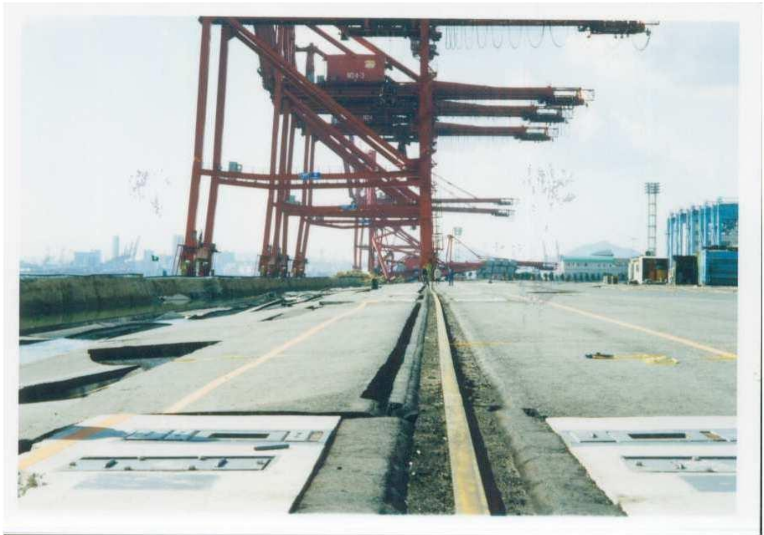
陸側レール基礎が地盤改良の場合 (六甲アイランド南側岸壁RC-5)
