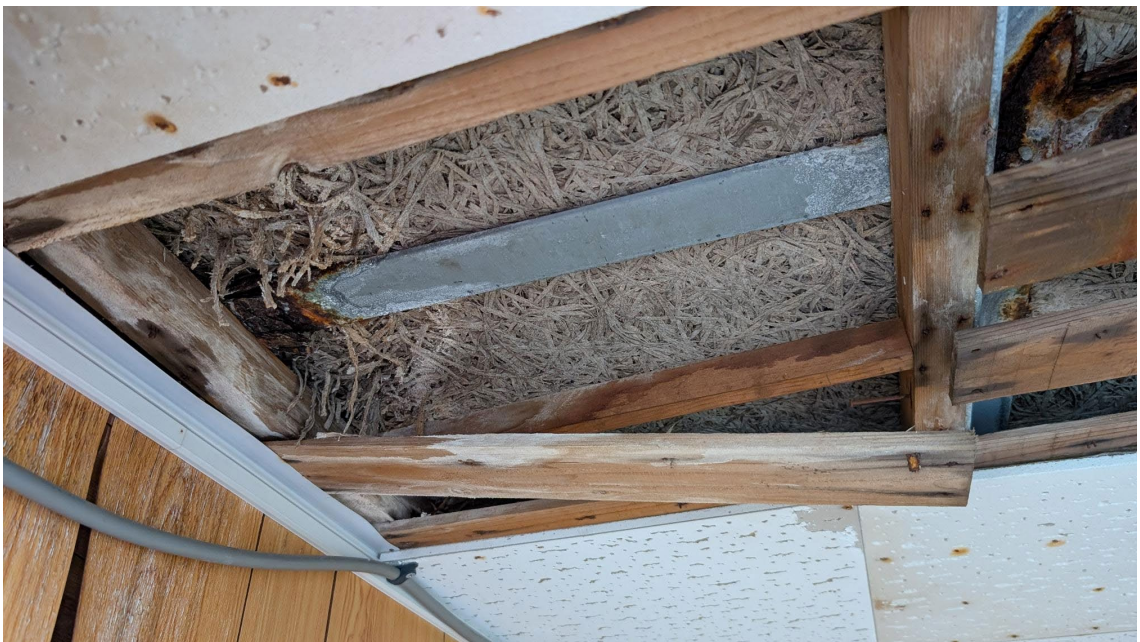
写真－4 内部・天井の状況
