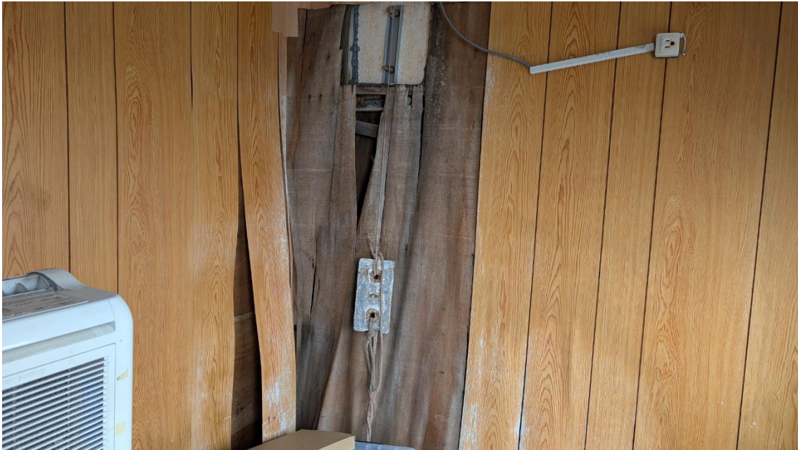
写真-5 内部・壁の状況 1
