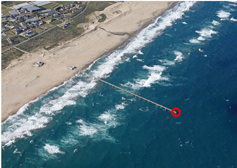
写真－1 波崎海洋研究施設（赤丸が先端観測所箇所）
