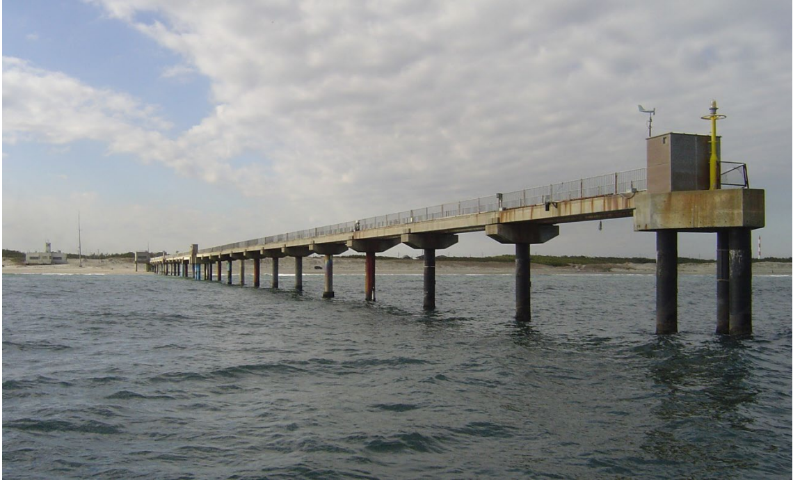
写真－3 先端観測所（海側から望む）
