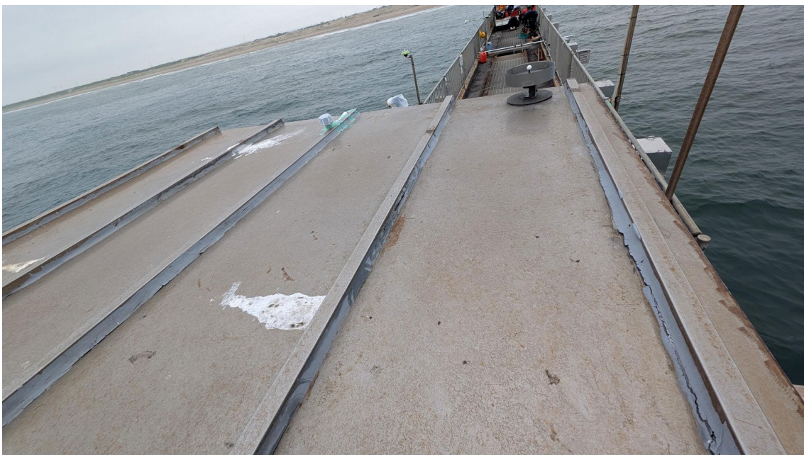
写真-8 外部・天井のシーリング状況
