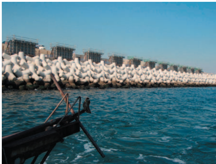
写真-3.6 D 滑走路埋立部沖側の消波ブロック
