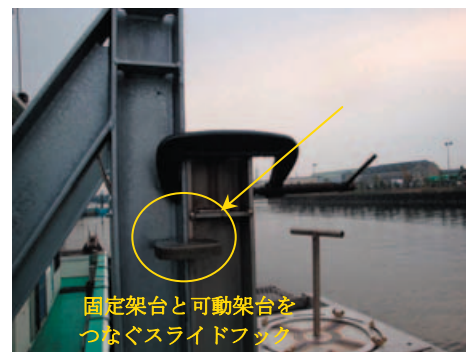
航行中は移動架台を引き上げ、 シャコ万力を使用し固定
