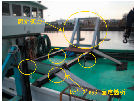
治具置台 (H 鋼 2 本) と船体を レバーブロックで固定
