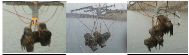
写真-8 脚ブロックの撤去
