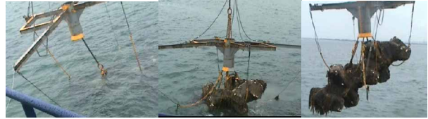
写真-9 水面下の視認不可10脚ブロックの撤去
