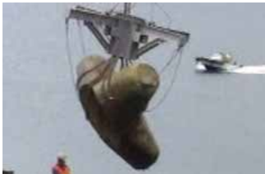
写真-16 破損ブロックの撤去
