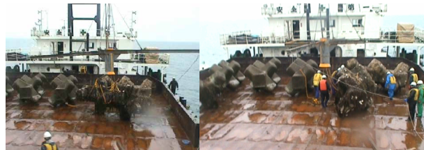
写真-10 起重機台船上へのブロック回収と解放
