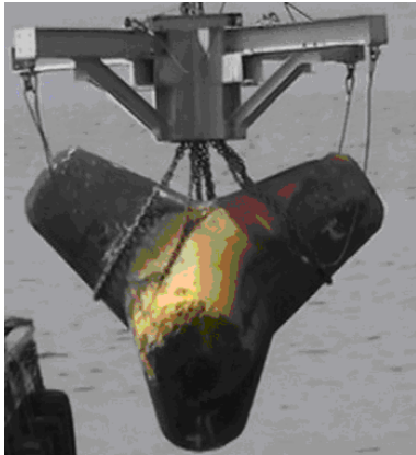
写真-15 小型化された支持枠
