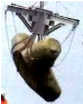
写真-21 実際の破損ブロックの吊り上げ
