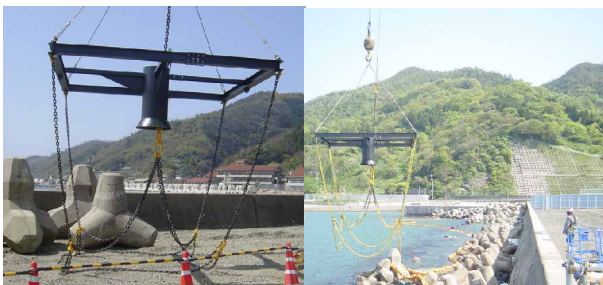
写真-5 6t用網チェーン式把持装置(左)と作業開始(右)
