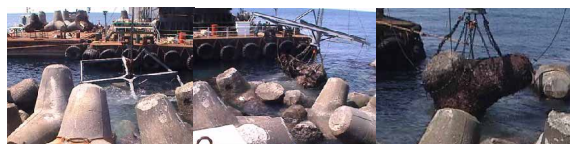
写真-13 水面下の破損ブロックの撤去
