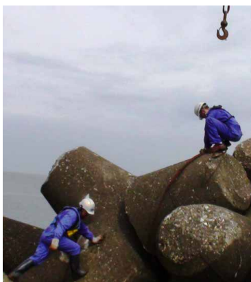
写真-1 作業員による玉掛け撤去
