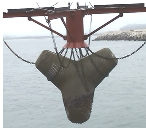
写真-20 実際のブロックの吊り上げ状況(ケース 3)
