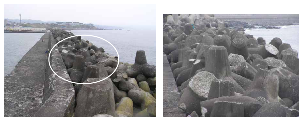
写真-12 ブロック撤去場所の状況
