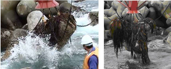
写真-18 荒天での作業(左)と海藻で覆われたブロックの撤去(右)
