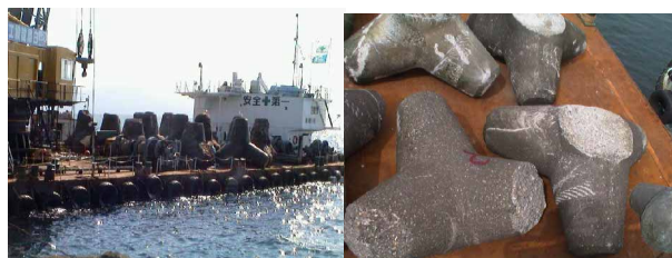
写真-14 起重機台船上への回収状況
