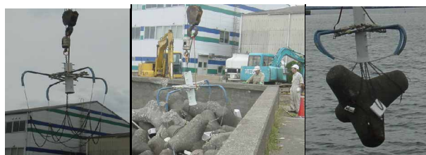
写真-4 2tブロック用網チェーン式把持装置
