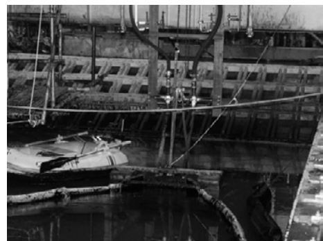
写真-5 実験模型設置状況
