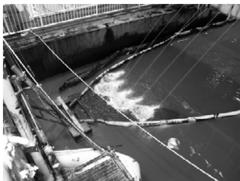
写真-7 放水銃による集油
