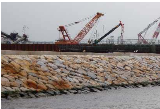
写真-5 海上試験場所の捨石マウンド（図-17）。
