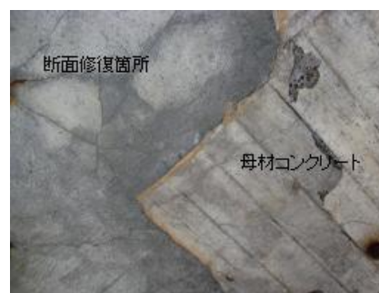
写真-1 栈橋上部工床版の断面修復の一例
