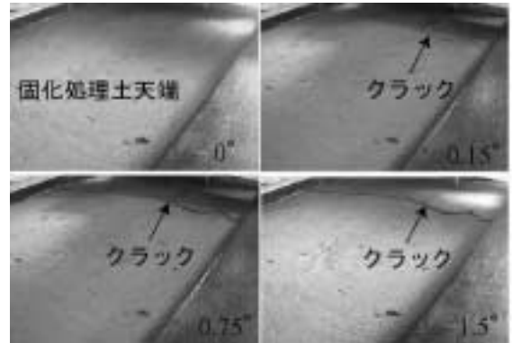
図-2.7 安定処理土天端の状況 (T000-15R)
