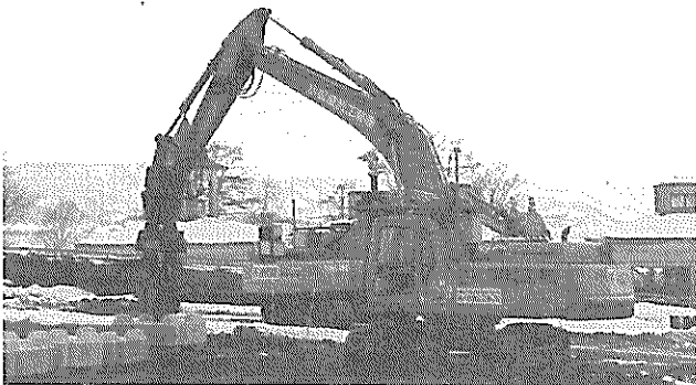
図-A.1 遠隔操作による導流堤設置工事
