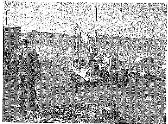
図-46 水中バックホウ投入状況
