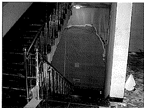
(3) 地下2Fへの階段通路
