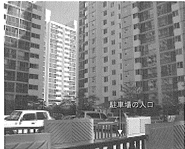
写真-2.13 高層マンション群と地下駐車場入口
