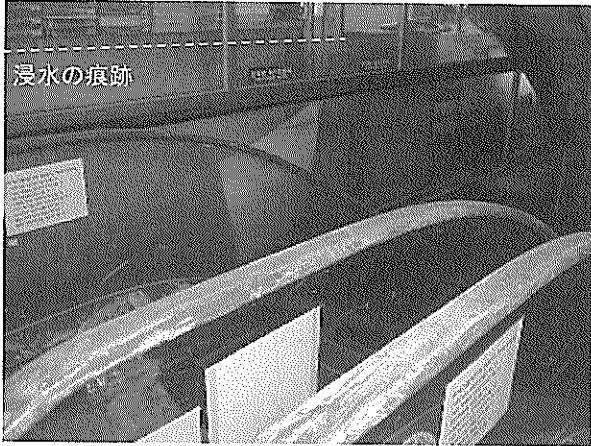
(a) 店舗1階のエスカレータ
