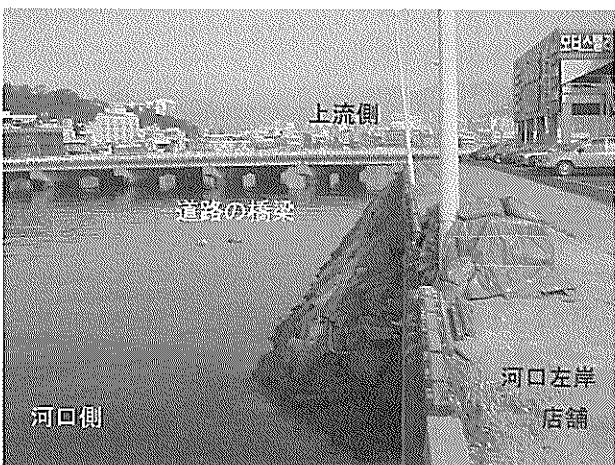
写真-2.2 河口の橋梁付近
