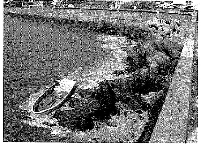
写真-4 隅角部 (一部ブロック積み)
