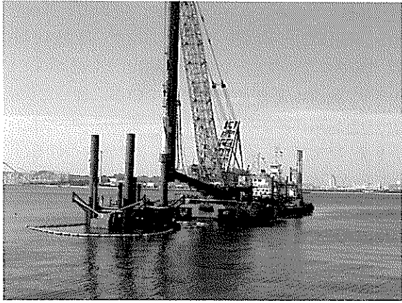
写真-2 杭打ち工事状況
