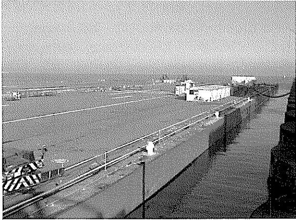
写真-3 メガフロート浮体設置状況
