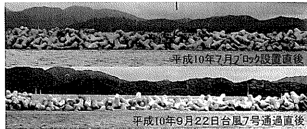
写真-2.3 平成10年被災状況
