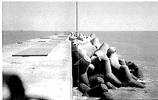
写真-2.6 消波ブロック前面での砂の舞い上がり (宮崎港南防波堤)
