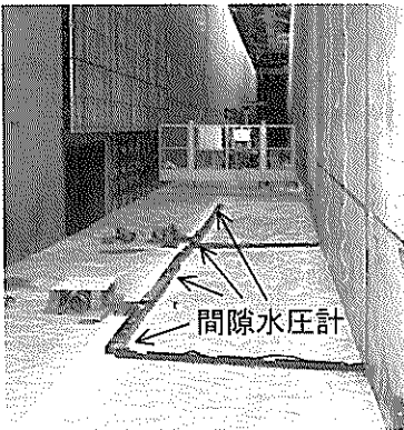
写真-4.14 計器設置状況
