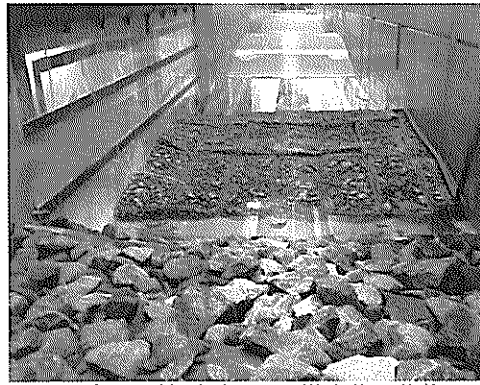
写真-4.9 被覆ブロック撤去後の状態
