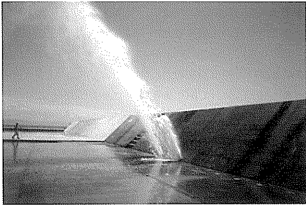
写真-2.4 ケーソンの穴あきによる噴水状況
