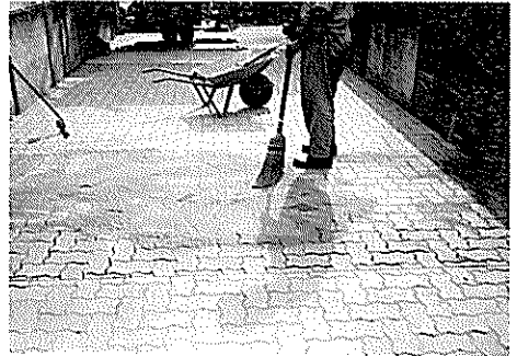
写真 13 砂の目地詰め状況
