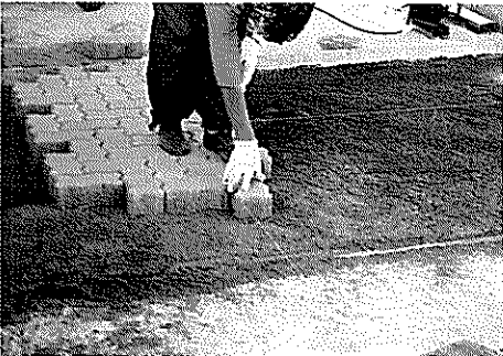
写真 11 ILBの敷並べ状況
