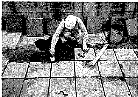
写真 6 モルタルの敷均し
