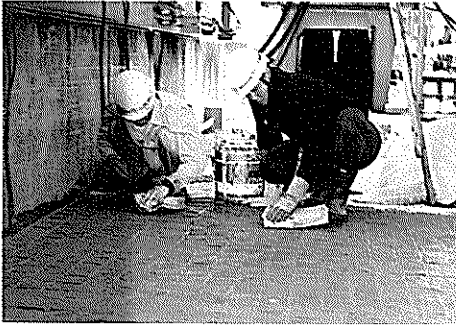
写真 9 流しモルタルの充填状況
