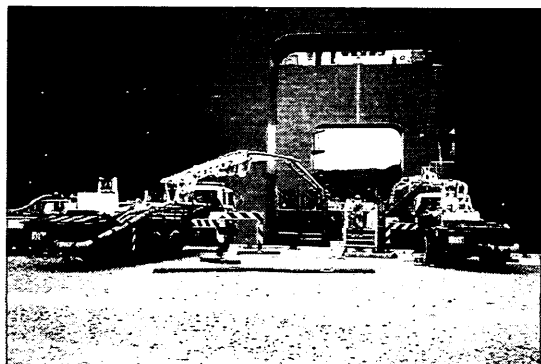
写真-4.2 ポンプ車の配置状況
