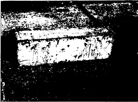
写真-21 暴露後の供試体の状況（塗装仕様2）
