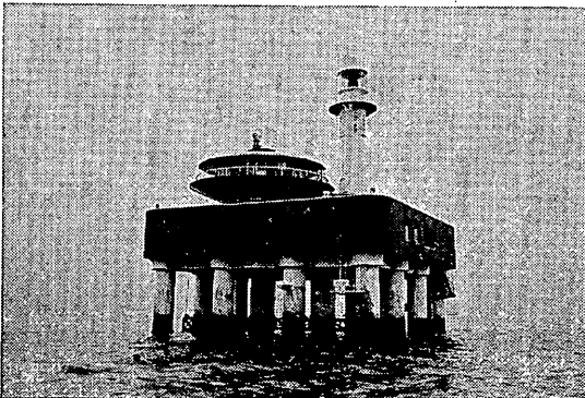
写真-2.1 東京灯標全景
