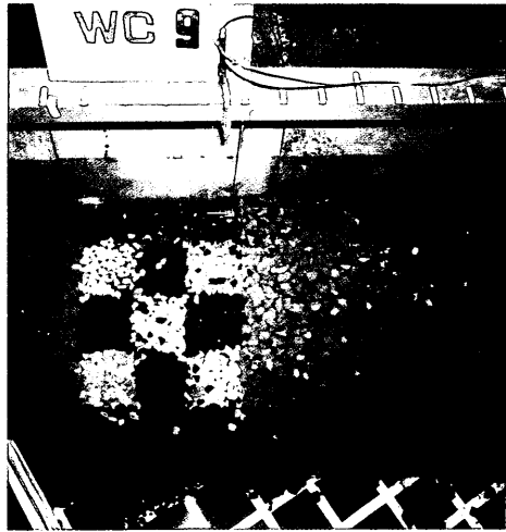
写真-4 斜め60°入射波に対する堤幹部の状況
