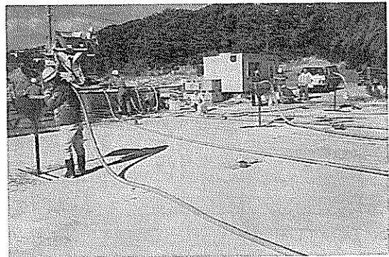
写真-6 グラウト作業の状況
