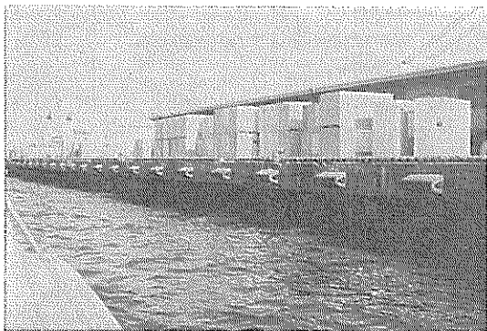
図-14 鉄筋コンクリート被覆工法の完成状況
