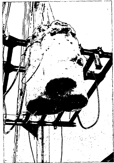
写真-1 処理土引上げ状況
