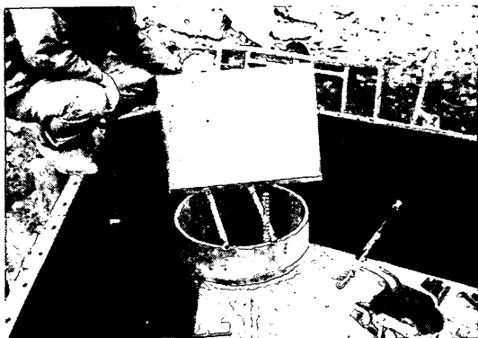
写真-2.7 鋼管杭頭沈下測定ロッド
