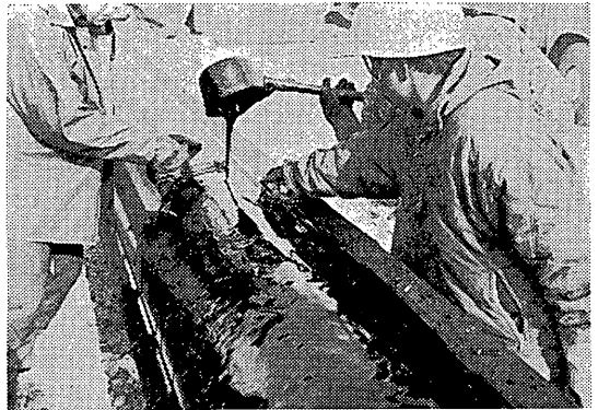
写真-2.5 アスファルト塗布
