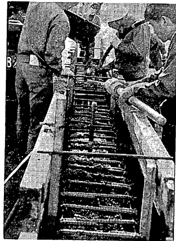
写真-2.2 コンクリートの打ち込み
