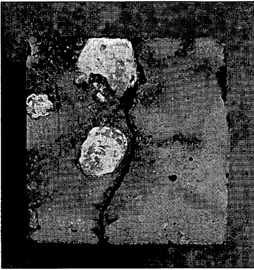
写真-3 はり下面の海中生物の付着状況 (写真上下ははり側面, 左右方向ははり軸)
