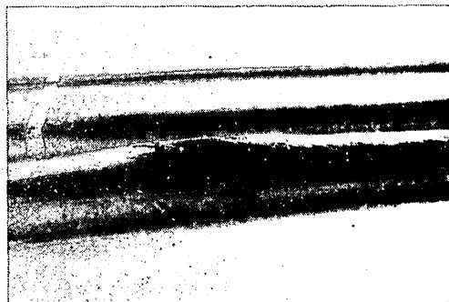
写真-4.3 大きなクラックの入ったワダチボレ
