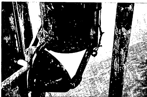
(e) 打設管先端、水密蓋
