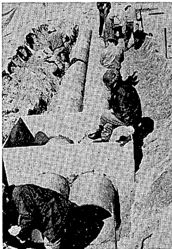
写真 3-1-3 複断面模型の埋設作業
