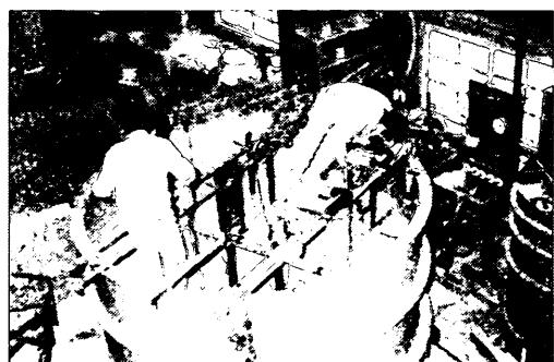
写真2 棒状バイプレーターによる砂の締め固め
