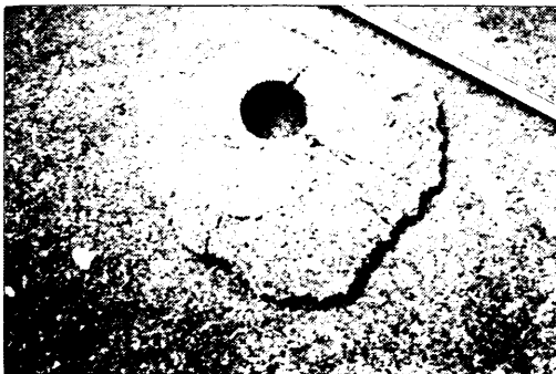
写真-3.2 貫入試験で表面に生じた辻り面の 1 例
