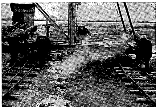
写-9 生石灰打設機の移動
