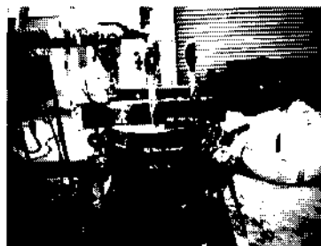
充填完了（観測孔や観測孔周辺のモルタル蓋から懸濁型薬液が流出）
