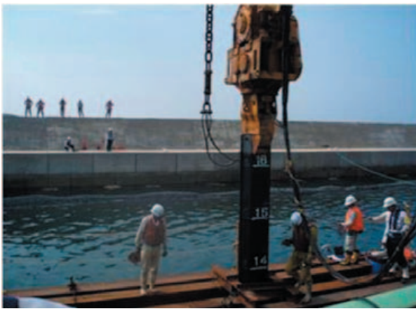
写真-3.1 試験施工での遮水鋼矢板の打設状況
