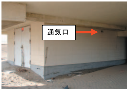
写真-16 倉庫の外観
