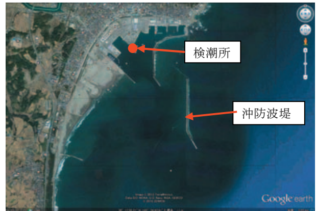
写真-15 大洗港検潮所
