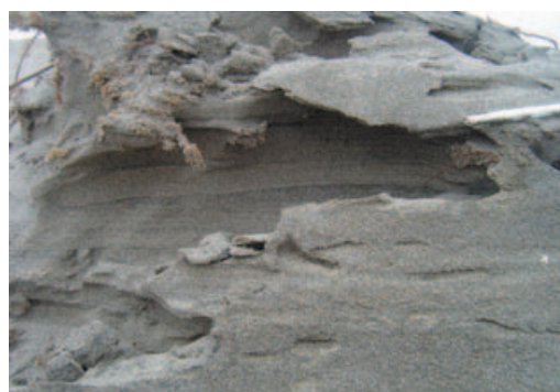
写真-7 細かな砂の露出 ( x=-120m, y=-80m 地点)
