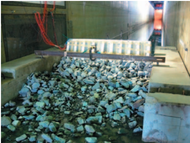
写真-3.17 波高0.9m作用後の裏込部の様子
