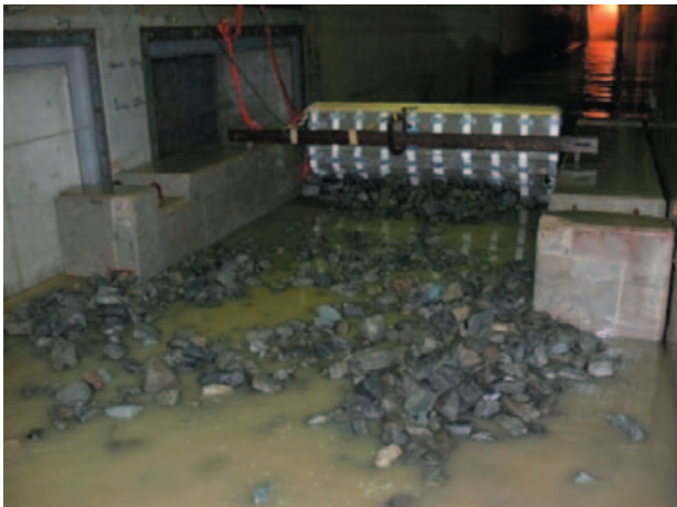
写真-3.20 波高 1.1m 作用後の裏込部の様子
