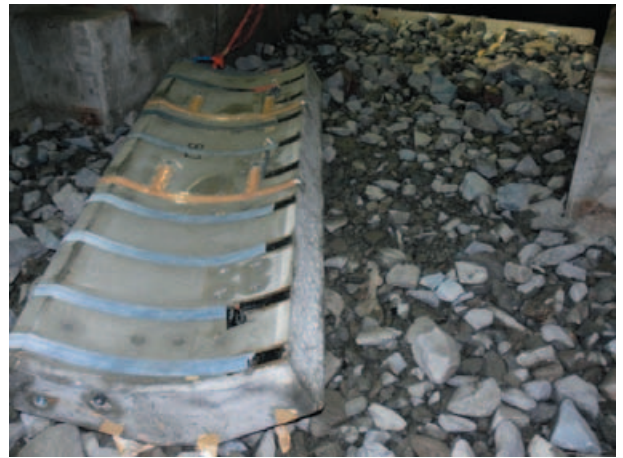
写真-3.18 波高1.1m作用後の裏込部の様子
