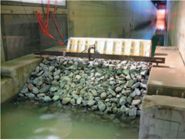
写真-3.15 波高0.5m作用後の裏込部の様子
