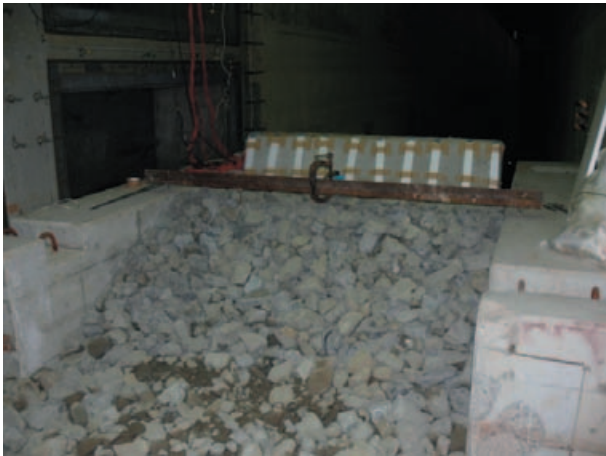
写真-3.21 ケース D13-5 実験前の裏込部の様子
