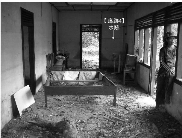
図-4.12 マラコパにおける浸水家屋内の痕跡（痕跡 4）
