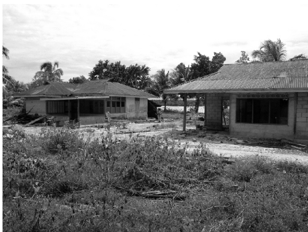
図-4.17 サウマングの被害状況
