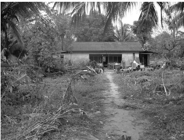
図-4.11 マラコパにおける浸水家屋内（痕跡 4）
