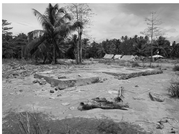
図-4.3 サベダングンにおける被害状況
