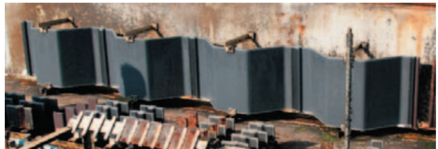
写真-4.9 大型供試体の暴露1ヶ月後の外観
