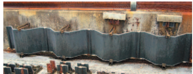
写真-4.10 大型供試体の暴露1年3ヵ月後の外観
