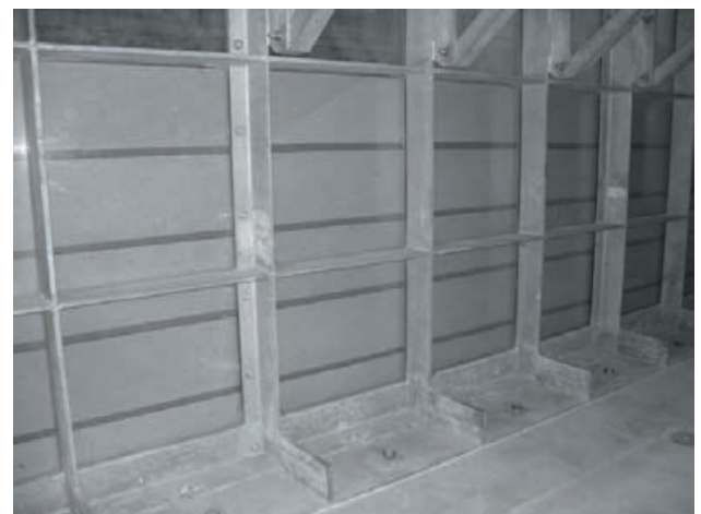
写真-2 色砂の敷設状況
