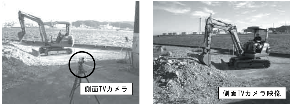
図-4.68 側面TVカメラ設置位置と映像
