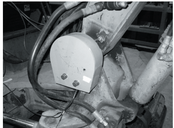
図-4.31 ブーム軸ポテンシオメータ取付状況
