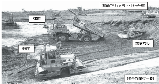
図-4.51 陸上遠隔操作((財)先端建設技術センター)
