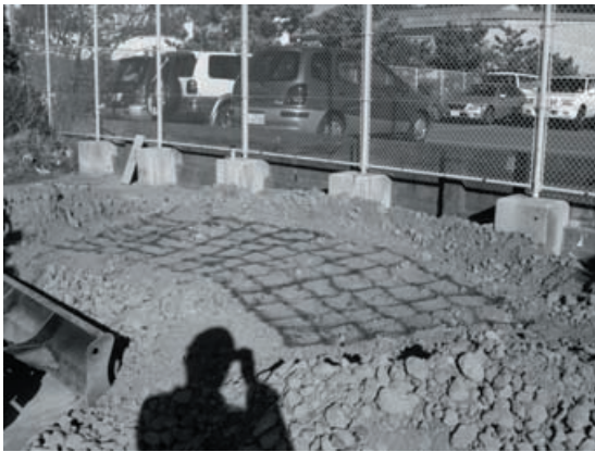
図-4.85 遠隔操作作業後のマウンド形状
