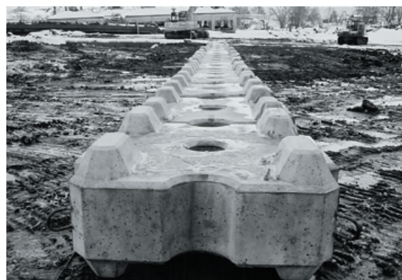
図-2.5 遠隔操作による導流堤ブロック設置状況
