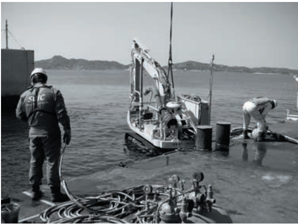
図-4.100 水中バックホウ投入状況
