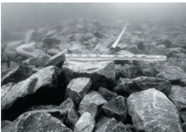
図-4.103 作業後のマウンド状況
