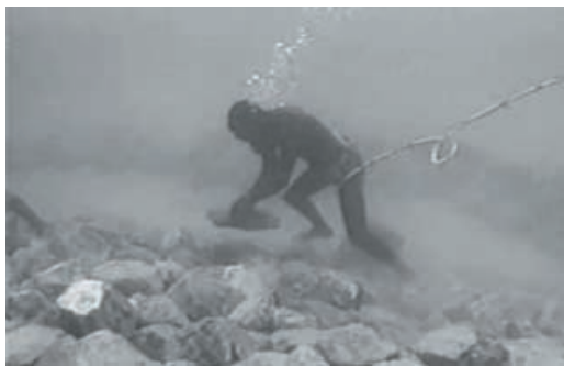
図-1.1 水中均し作業(佐伯建設工業広報ビデオより)
