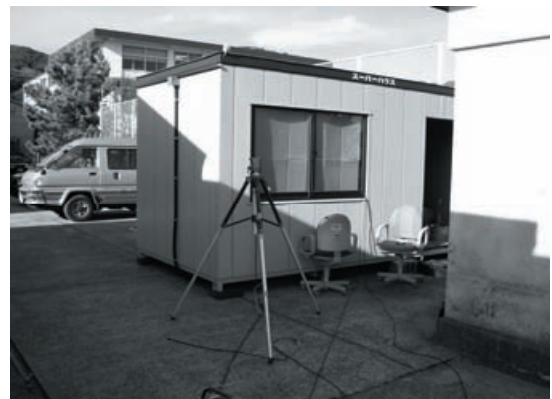
図-4.77 遠隔操作制御室
