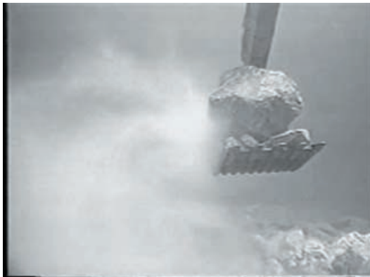
図-1.8 水中バックホウによる均し作業 (佐伯建設工業株式会社広報ビデオより)
