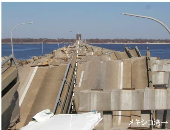
写真-2.4.10 ビロキシと対岸を結ぶ橋桁の落下
