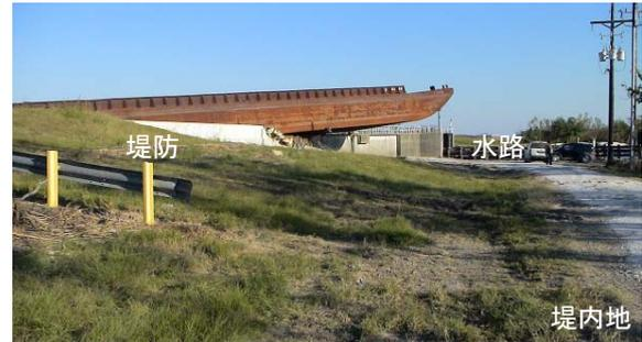
写真-2.4.6 Inner Harbor Navigation Canalの堤防に乗り上げたバージ
