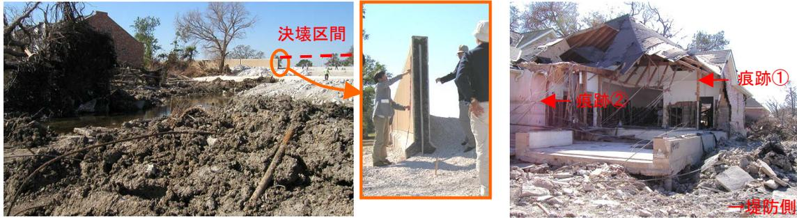
(a) 破堤区間と堤防の断面
