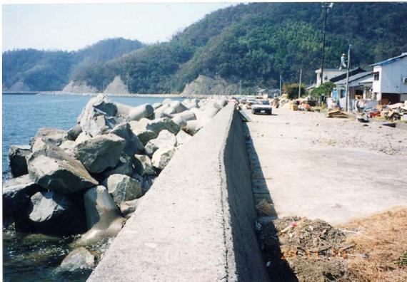
写真-2.2.3 住宅地前方の消波工被覆護岸
