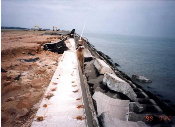
写真-5.5 想定外の外力による護岸の破壊
