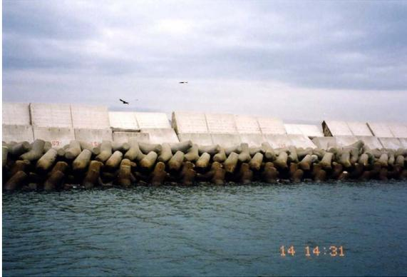
写真-2.2.6 沖合土砂処分場の護岸
