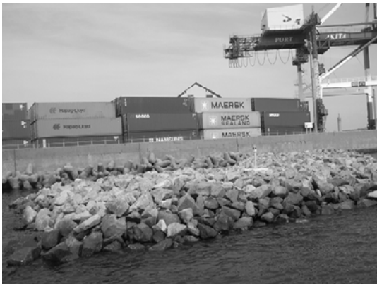
写真-2 秋田港内の外港地区の様子
