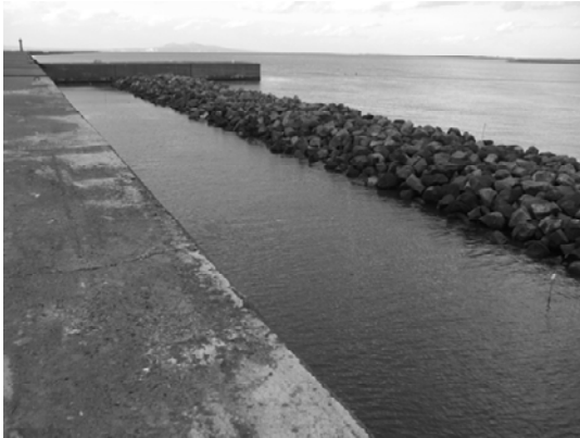
写真-1 秋田港内の長周期波対策工(図-20の'沖側')
