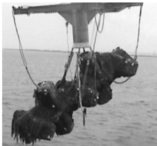
写真-15 12.5t-5m 長ブロック回収
