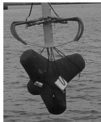
写真-6 2t 4脚ブロックの吊り上げ
