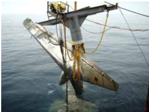
写真-29 海面上への引き揚げ（その2）
