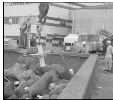
写真-5 2t用網チェーン装置による作業状況
