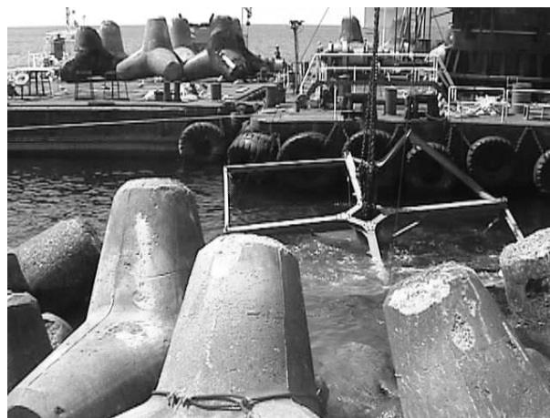
写真-18 25t ブロックの回収作業
