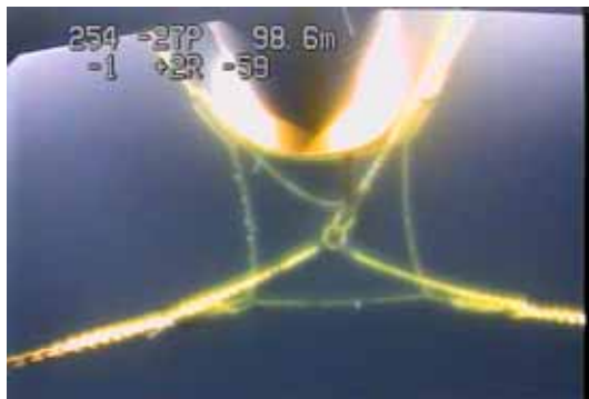
写真-24 降下中の状況
