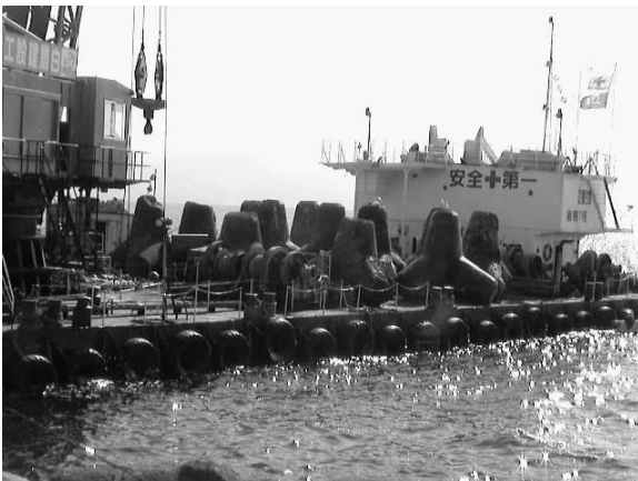
写真-20 25t ブロックの台船上への回収状況
