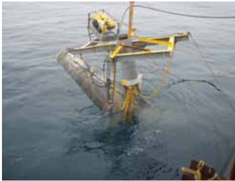
写真-28 海面上への引き揚げ（その1）
