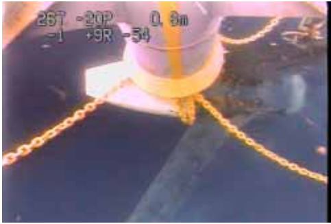
写真-27 海中引き揚げ時の状況
