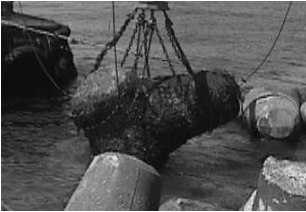
写真-19 25t 破損ブロックの回収作業
