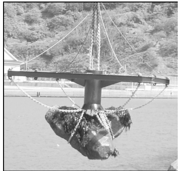
写真-12 破損ブロックの回収
