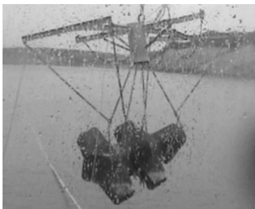
写真-13 7.5t-3m 長ブロック回収
