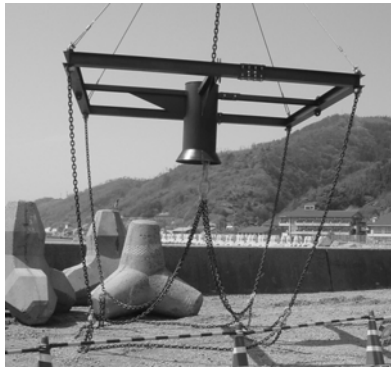
写真-7 6t用網チェーン式回収装置
