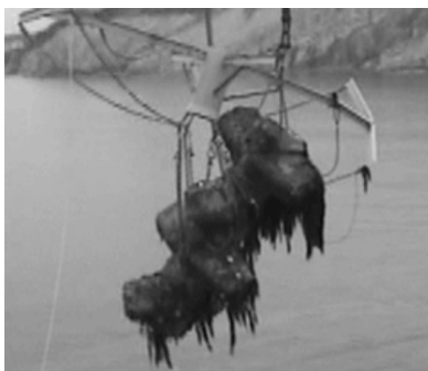
写真-14 10t-4m 長ブロック回収
