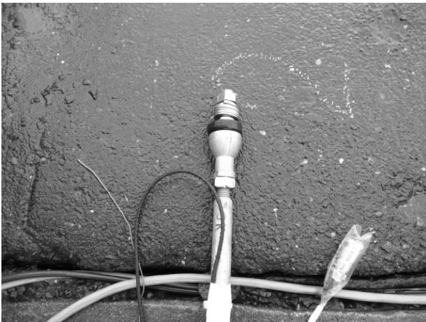
写真-D.7 支柱の上端部
