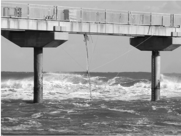
写真-2 観測栈橋に設置された振子型流速計
