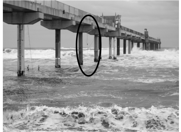
写真-D.18 栈橋と振子型流速計（中央円内）
