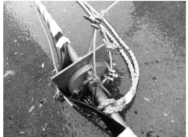
写真-D.9 支柱中央部のジョイント
