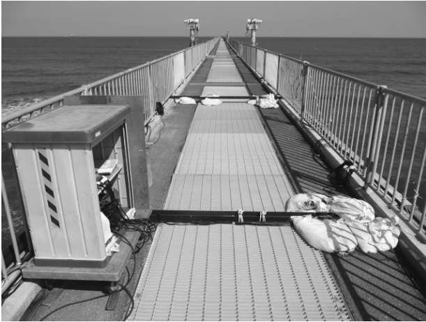
写真-D.16 観測システム設置後の栈橋上の様子
