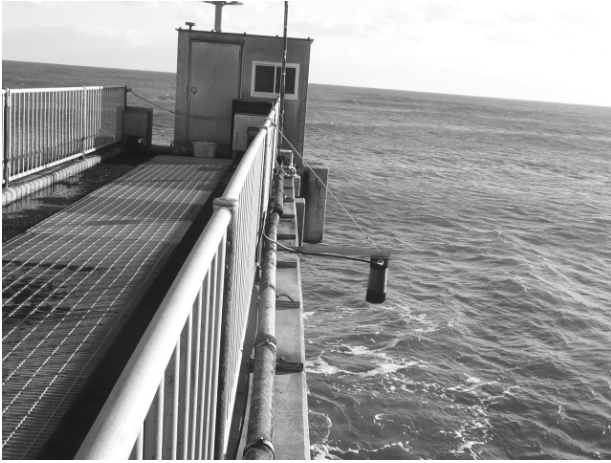
写真-D. 21 棧橋先端 (X = 378 m) に設置された超音波式波高計
