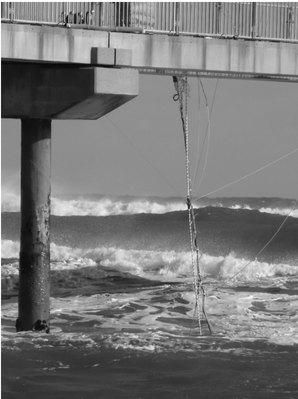
写真-D.17 振子型流速計の全景
