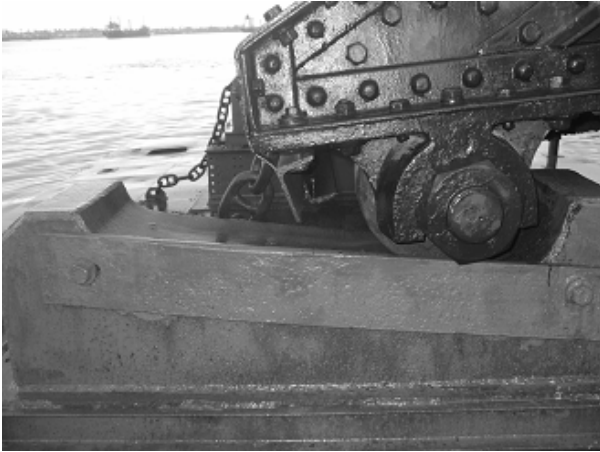
写真-3 連絡橋と浮き基礎の接続部
