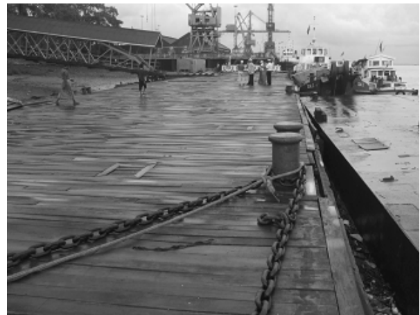
写真-6 残存した浮き栈橋の外観
