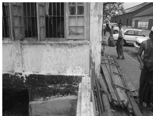
(a) 護岸上の監視家屋（本文 写真-1の右端家屋）
