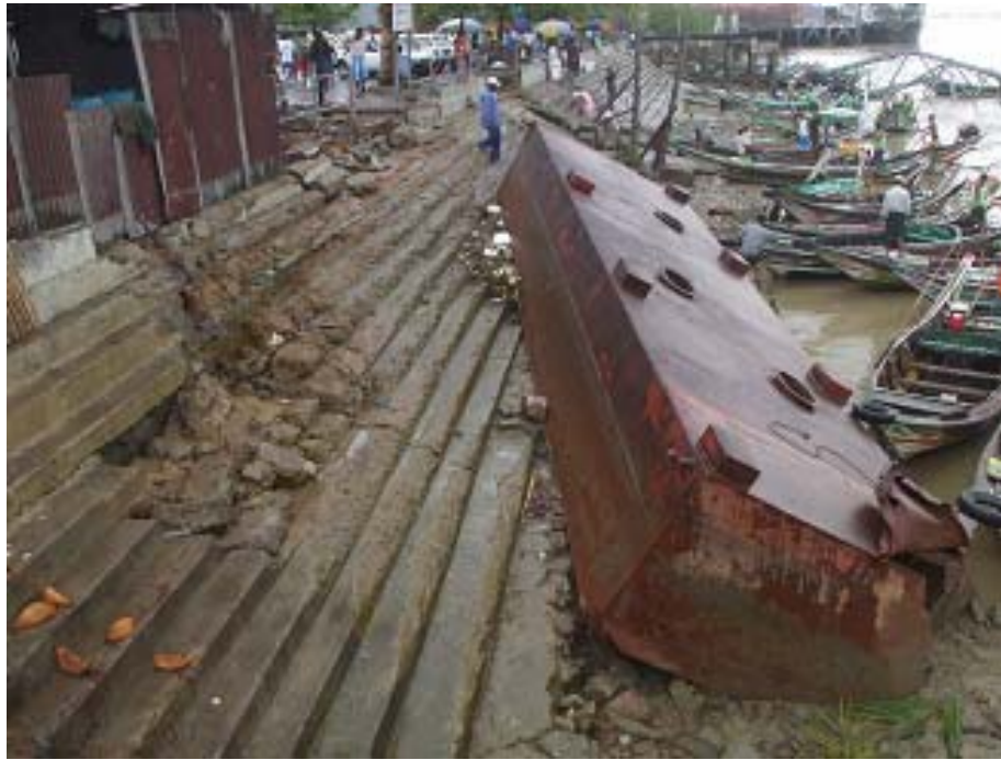
巻頭写真-3 護岸に衝突したポンツーン
