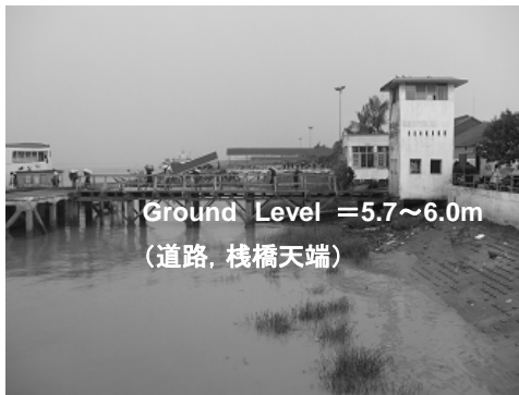
写真-2 栈橋天端と護岸・道路面の関係
