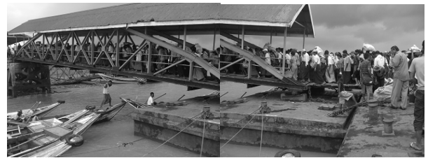
写真-5 復旧された連絡橋・浮き基礎・ポンツーンの使用状況
