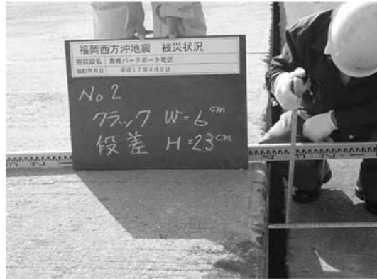
6 NO.2 上部工最大沈下(H=246mm)
