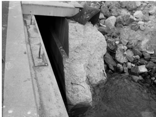
写真-4.6.2 復旧前の上部コンクリートと渡版
