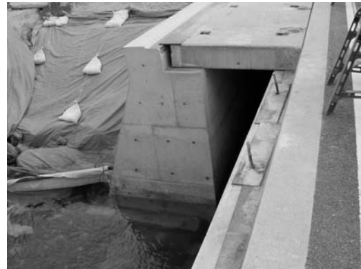
写真-4.6.3 復旧後の上部コンクリートと渡版
