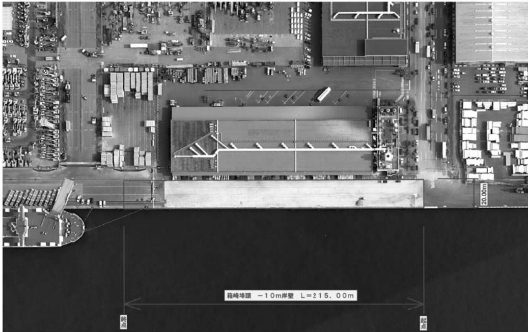
箱崎埠頭 -10m岸壁 全景
