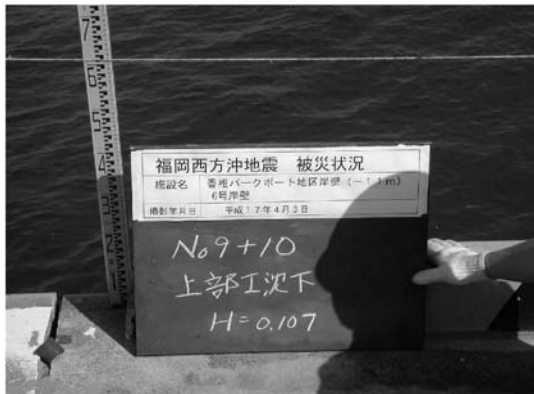
5 NO.9+10.0 上部工最大沈下(H=107mm)
