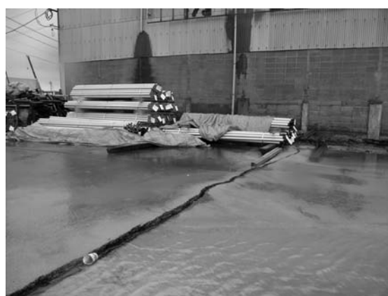
写真-4.3.4 中央埠頭北側-5.5m岸壁の背後における液状化発生状況
