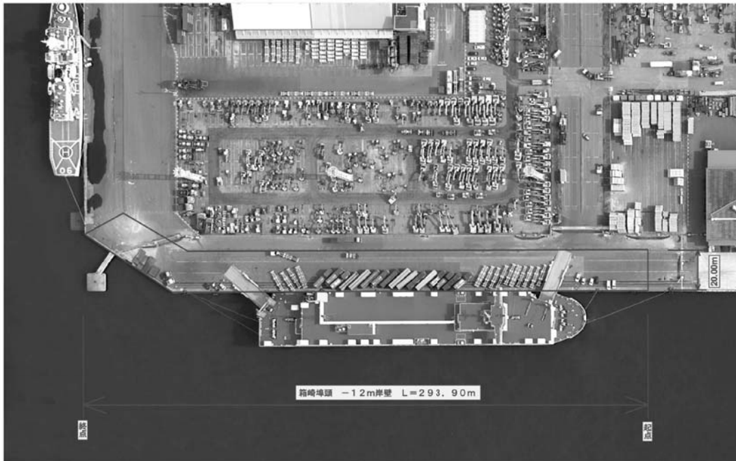
箱崎埠頭 -12m岸壁 全景
