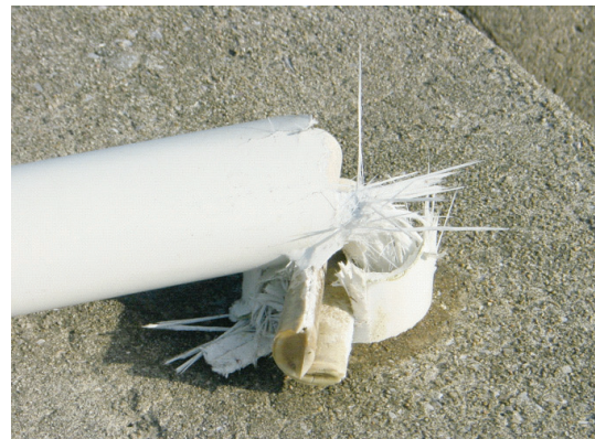
写真-2 支柱の被災状況
